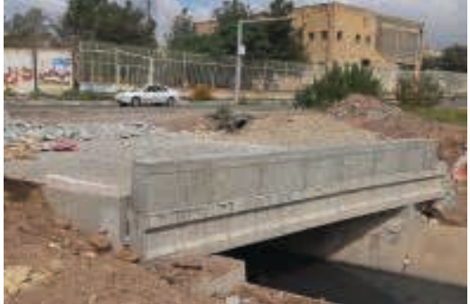
پروژه تعریض پل بتنی روی کانال آر
