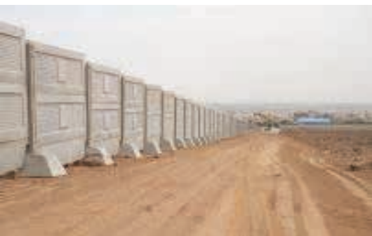
پروژه خرید و اجرای دیوار پیش ساخته پیرامونی و ایجاد سکوهای اسکان اضطراری بوستان بام قیامدشت
