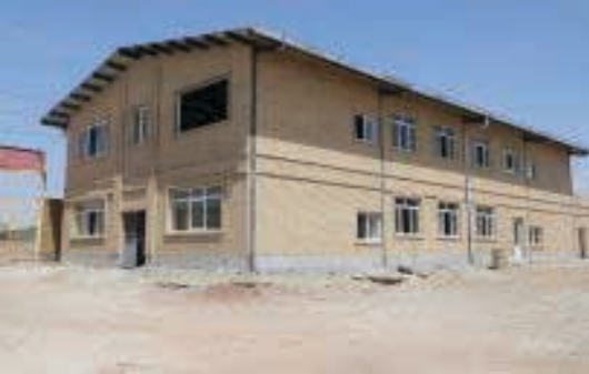
پروژه احداث ساختمان خدمات شهری و تکمیل سوله بحران و محوطه سازی
