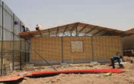
پروژه احداث رختکن و مدیریت و اجرای حصار کشی پیرامون زمین فوتبال ورزشگاه ه هزار نفری
