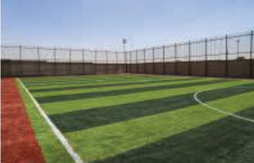
پروژه احداث چمن مصنوعی و انبیه مورد نیاز واقع در محوطه
