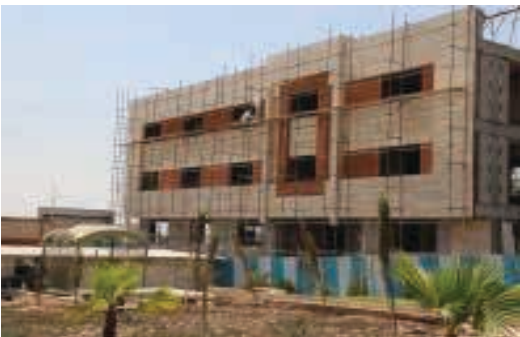
• پروژه احداث ساختمان شهرسازی و درآمد
